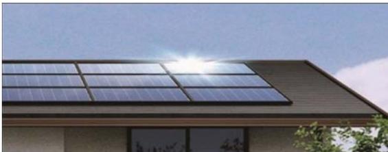
展示場では太陽光発電システムと蓄電システムを搭載※しております。蓄電システムを搭載することによって、停電時には自動的に供給電力を蓄電池(2.07kWh 1500W)に切り替え、予め設定しておいた家電製品を継続して使用することができます。例えば32型液晶テレビ(150W)＋冷蔵庫(200W)＋エアコン(200W)＋ノートパソコン(50W)＋扇風機(50W)＋LED照明(15W)を組み合わせた場合、約3時間の利用が可能です。
